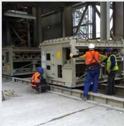
ETA Cooler installation.
